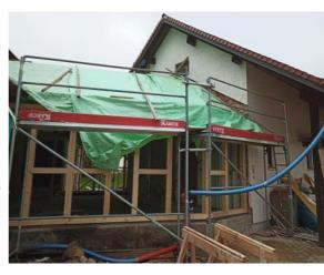
Die aus Faserzementplatten bestehende Dach- und Fassadenverkleidung wurde asbestfrei ersetzt. Dachaufbau, innenliegende Holzschalung und Dämmung wurden erneuert. Der außenliegende Glockenstuhl mit Holzkreuz wurde instandgesetzt.
